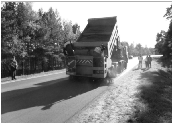
Рисунок 3 – Распределение песка по нанесенной пропитке
