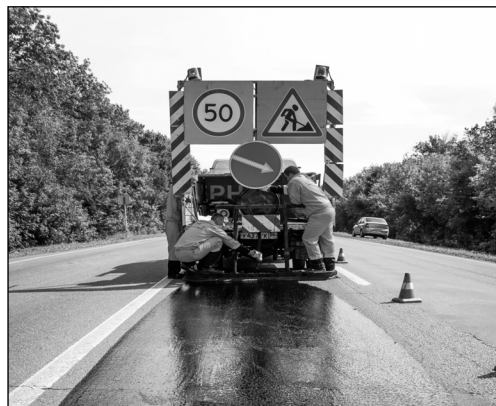
Рисунок 5 – Нанесение пропиточного состава с помощью специально оборудованной машины
